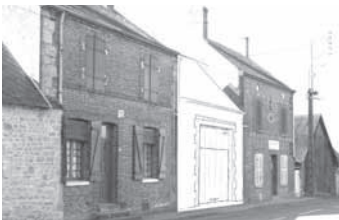
Après : mise en valeur de la baie
