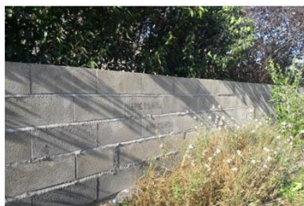
Mur plein en béton non crépis
