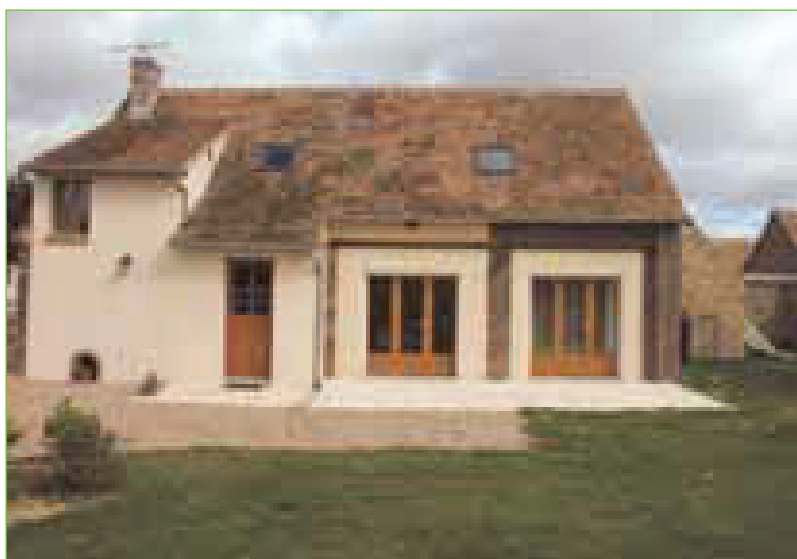
La grange réaménagée en gîte au printemps 2007.
