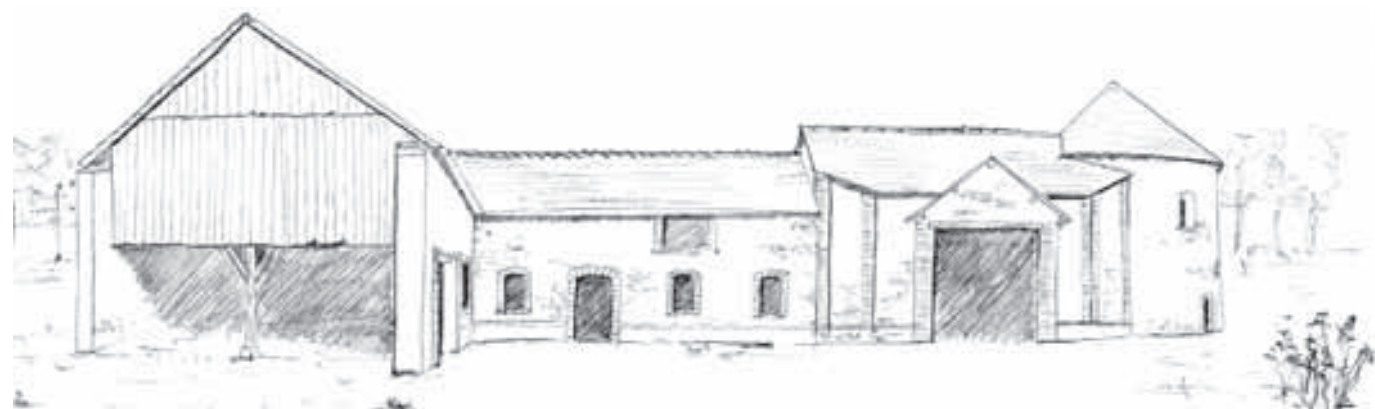
Façade est des granges.
