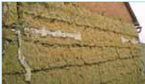
Mur en bauge. Broué.
