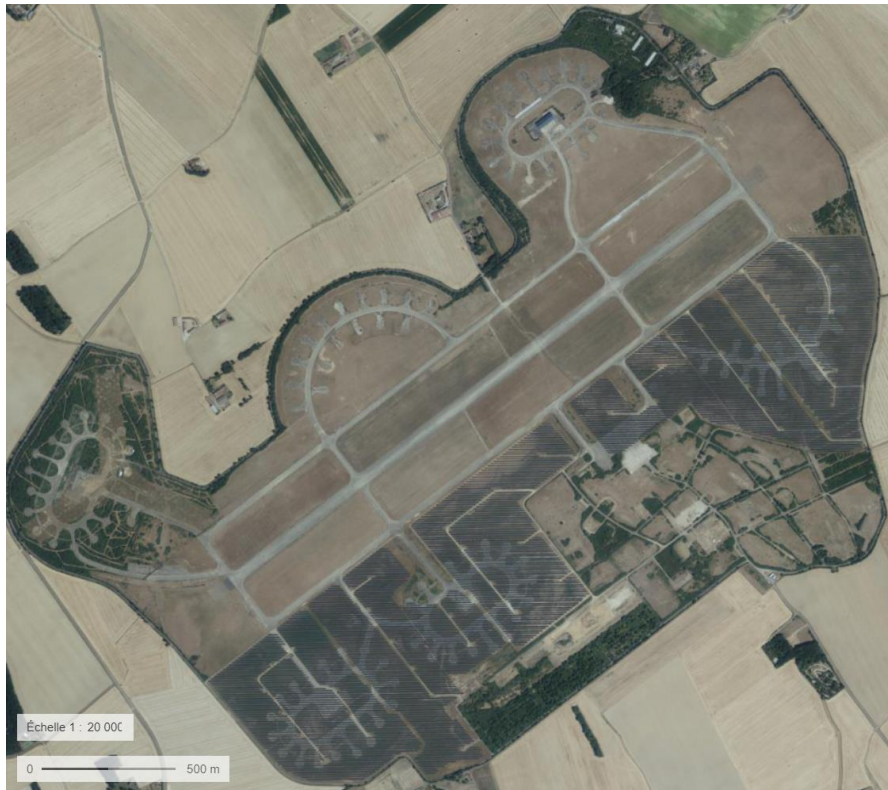
Centrale photovoltaïque de Crucey – Source : Géoportail
