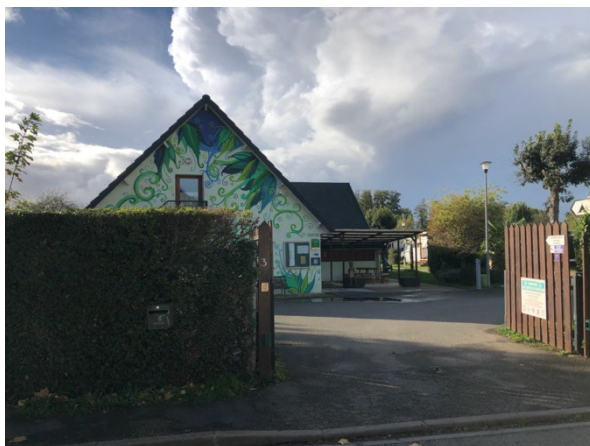
Figure 68 camping des étangs de Marsalin
